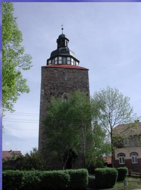
Мäuseturm Мышиная башня
