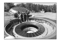
Современные шахтные пусковые установки обеспечивают защиту стартового комплекса от близкого ядерного взрыва
