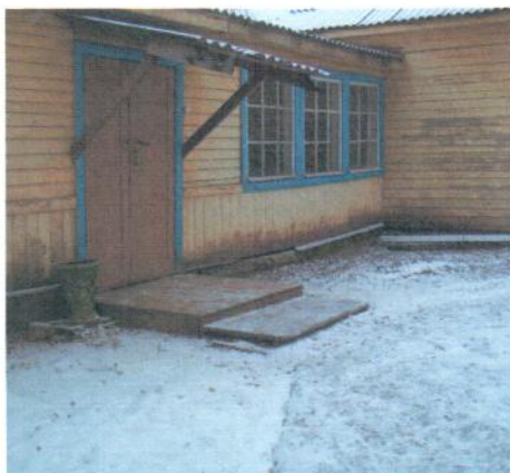
Фото №5 входная площадка (перед дверью)
