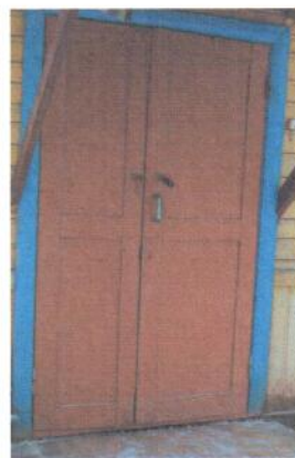
Фото №6 дверь (входная)
