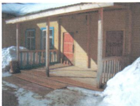
Фото №5 входная площадка (перед дверью)
